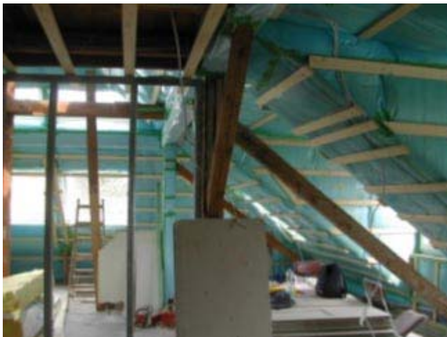
izda) El aislamiento es aún visible (planchas y paneles de madera): Este el momento óptimo para una medición BlowerDoor.
